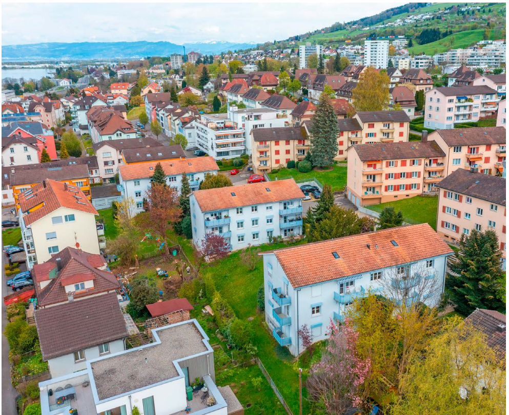
Wohnbaugenossenschaft St. Gallen, Felsenbergstrasse, Rorschach
